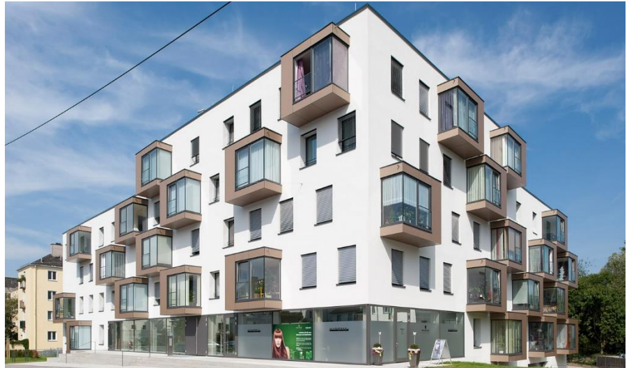
Ansicht Südostfassade (Foto: Henning Koepke) © Henning Koepke, München
