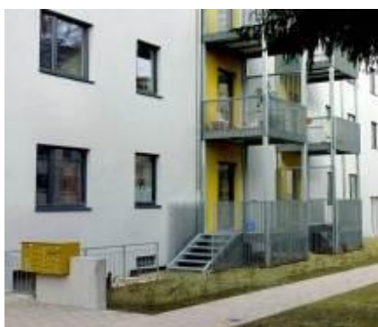
Balkone zum Innenhof (Foto: urban3 Architekten, Stuttgart) © urban3 Architekten, Stuttgart
