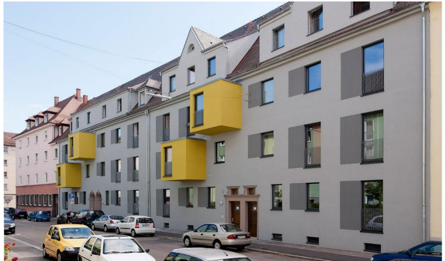
Straßenfassade (Foto: Henning Koepke) © Henning Koepke, München
